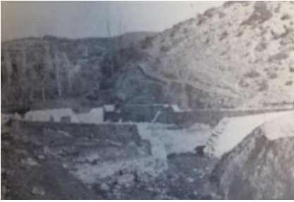
Η κατασκευή της δεξαμενής
