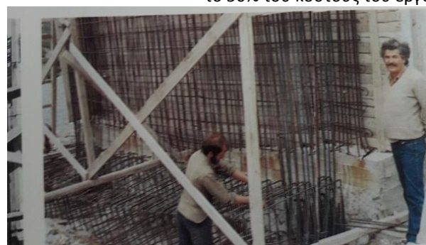
Εικόνες από την κατασκευή του Μνημείου
