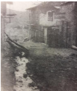
Το στενό πριν την τσιμεντόστρωση
